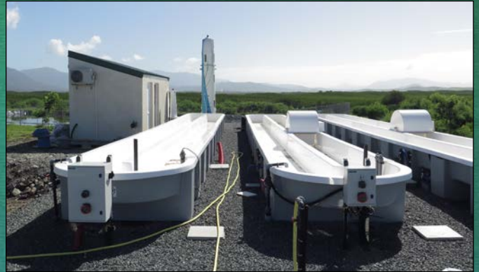
Raceways du LTMA à Koné (6 m3) et colonne COLDEP en arrière-plan
